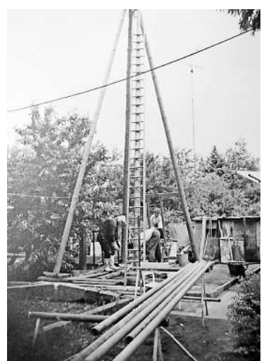
Nach 1945 erfolgten die Bohrarbeiten noch in schwerer Handarbeit. FOTO: PRIVAT
