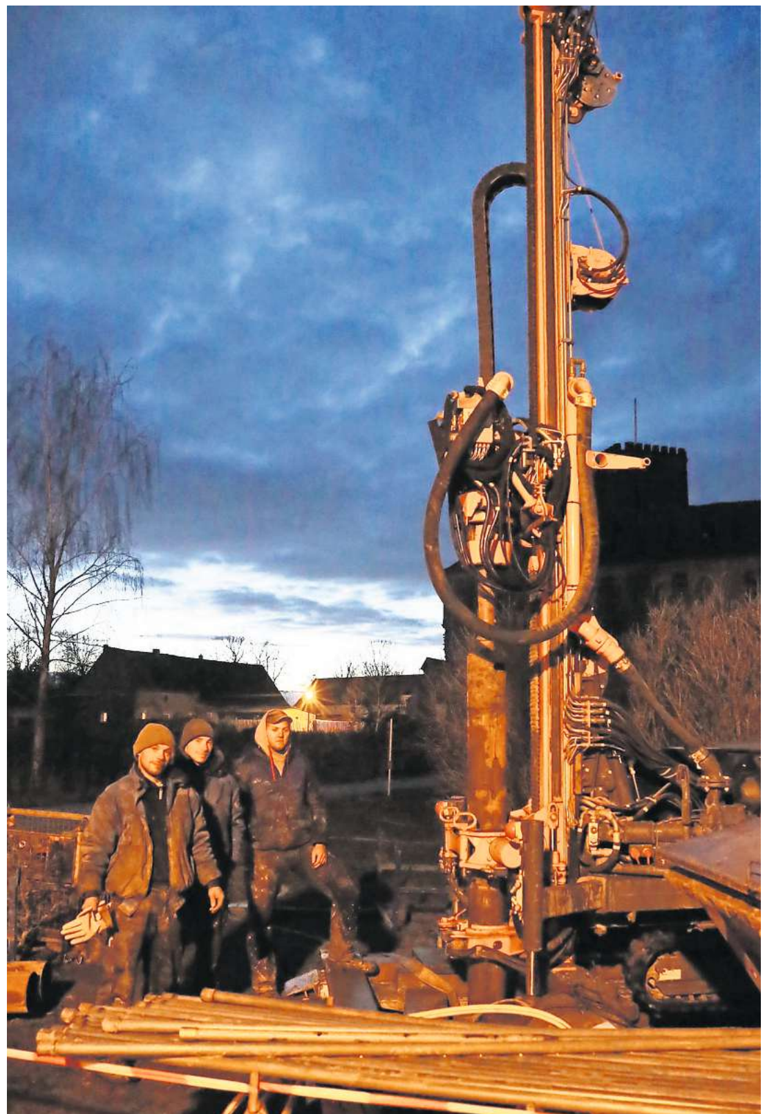
Das Team von Engelmann Brunnenbau und Erdwärme Bad Düben an einer Bohrstelle im Schlosspark Schnaditz.
